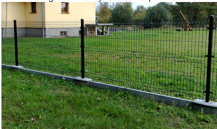
Fot. 1 Przykład ogrodzenia z paneli z drutu stalowego
