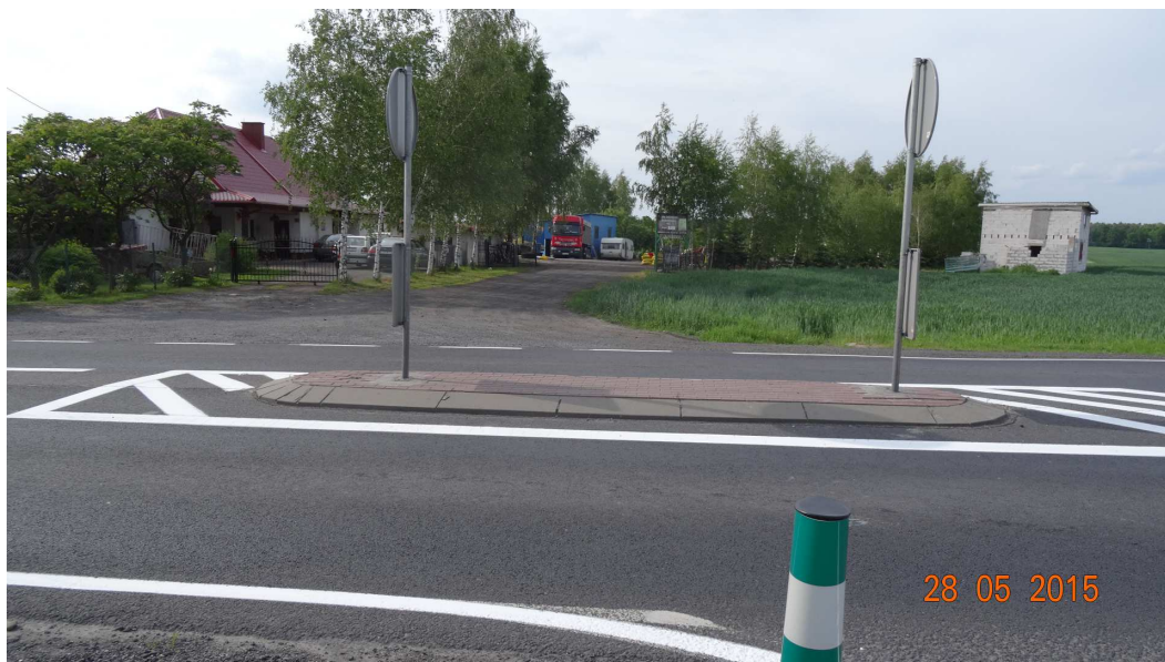
Fot. 5 Przejazd rowerowy „sugerowany” przed wyspą kanalizującą, w km 109+685,00 drogi krajowej nr 55
