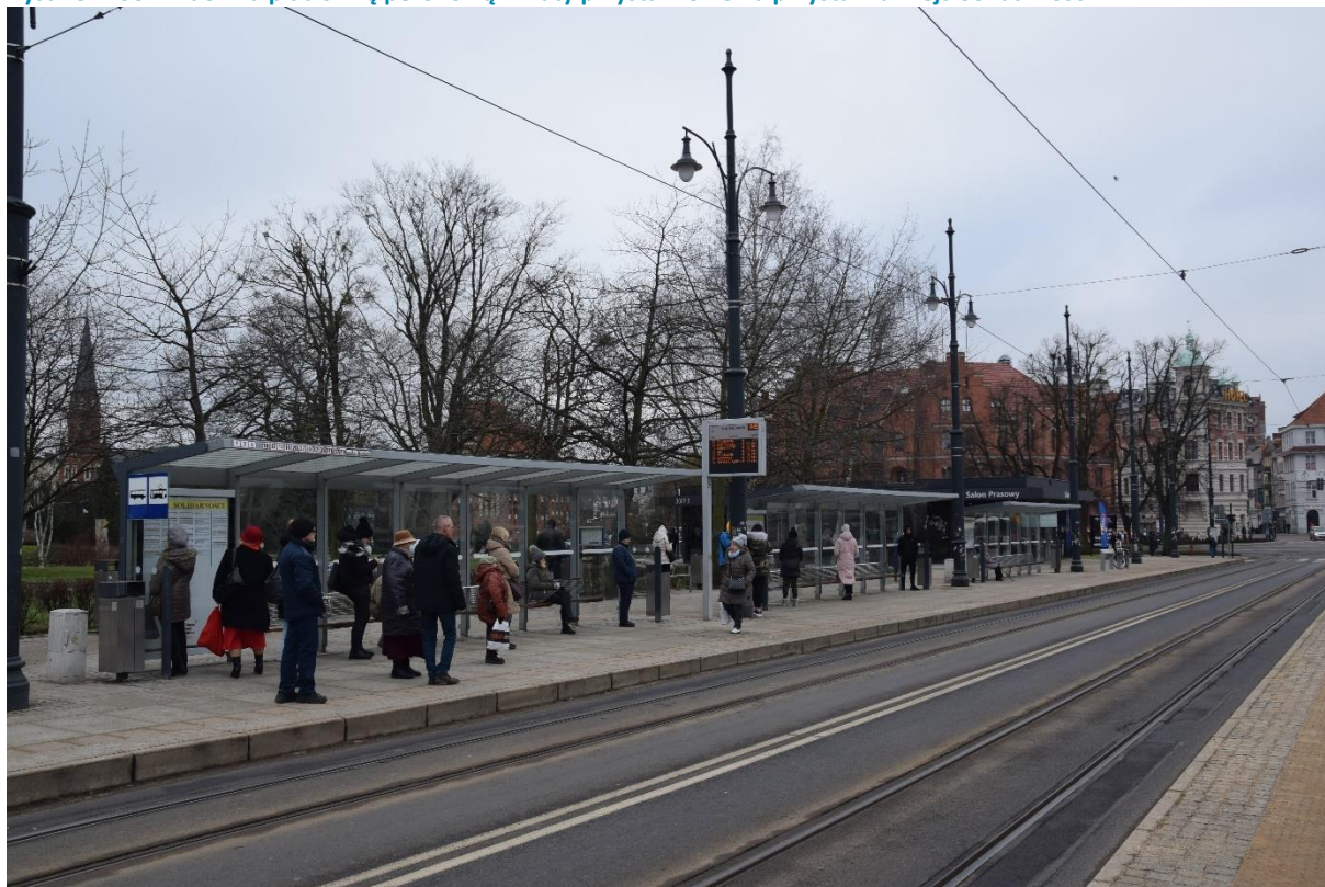
Rysunek 138. Widok na platformę peronową i wiaty przystankowe na przystanku Aleja Solidarności .
