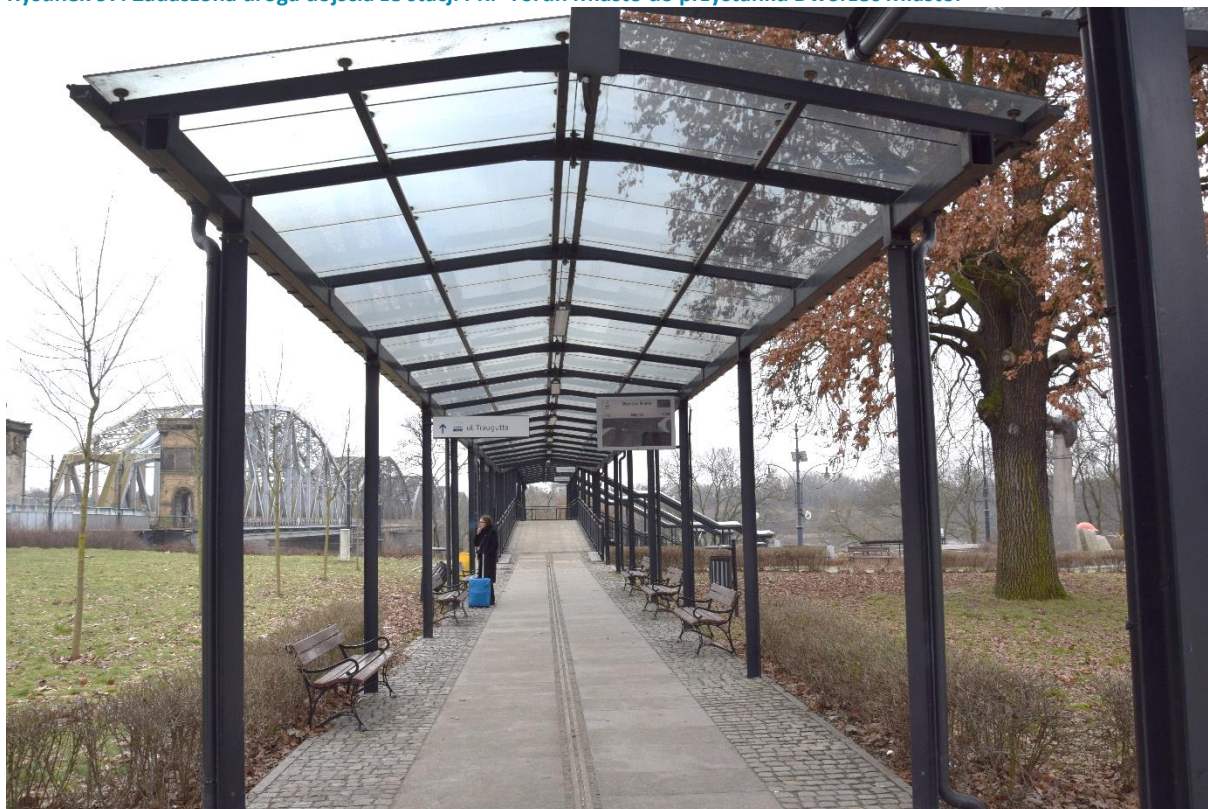
Rysunek 97. Zadaszona droga dojścia ze stacji PKP Toruń Miasto do przystanku Dworzec Miasto.
